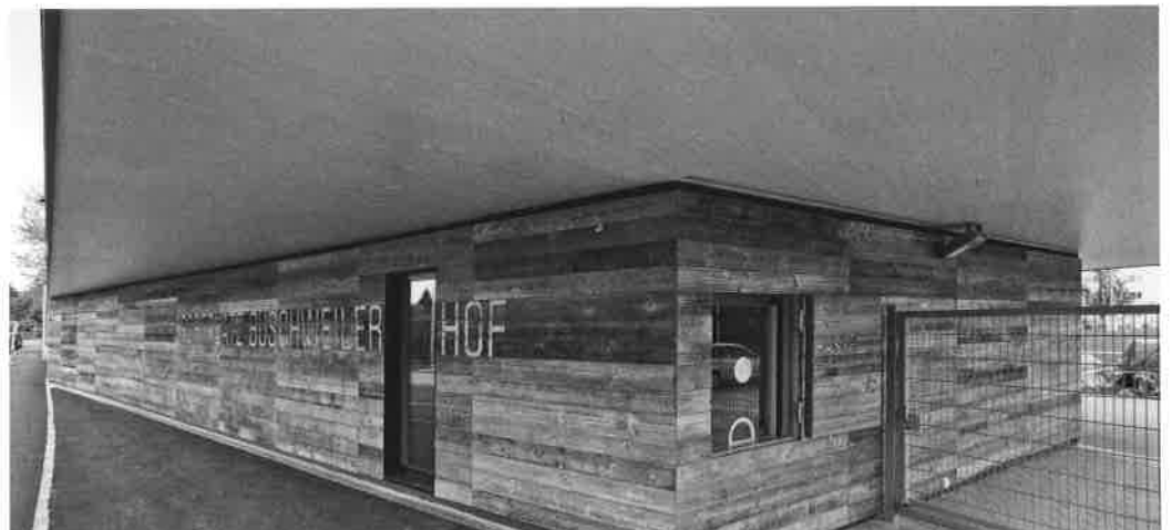
Von der Strasse zurückweichende Fas- saden spielen überdachte Zonen frei,
